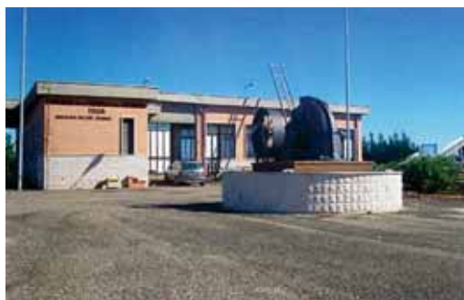
Fig.3. Impianto idrovoro di Palude Grande (agro di Lesina).
